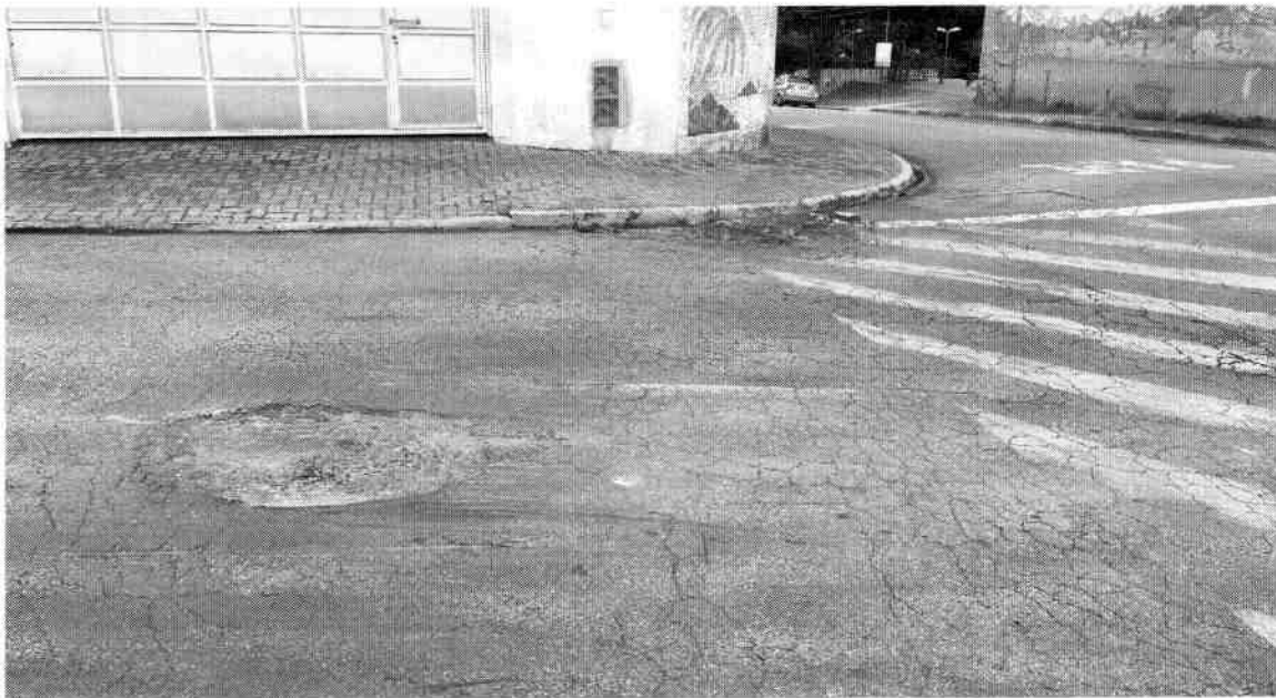
MANUTENÇÃO ASFÁLTICA EM TODA A EXTENSÃO DA RUA GRAMADO, CONJUNTO DO BOSQUE – MOGI DAS CRUZES.
